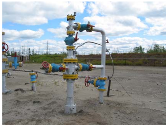
Рис. 1. Запорная и фонтанная арматура нефтяной скважины
